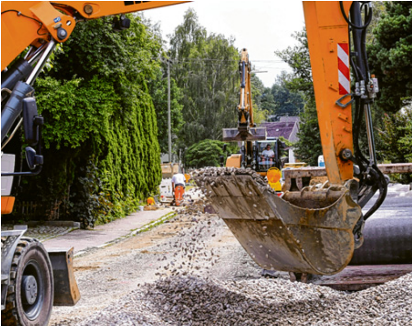
In der Hauptstraße haben die Bauarbeiten begonnen. Bevor sie im Rahmen der Dorfenerneuerung umgestaltet wird, werden Wasserleitung und Regenwasserkanal erneuert. Foto: Marcus Merk
